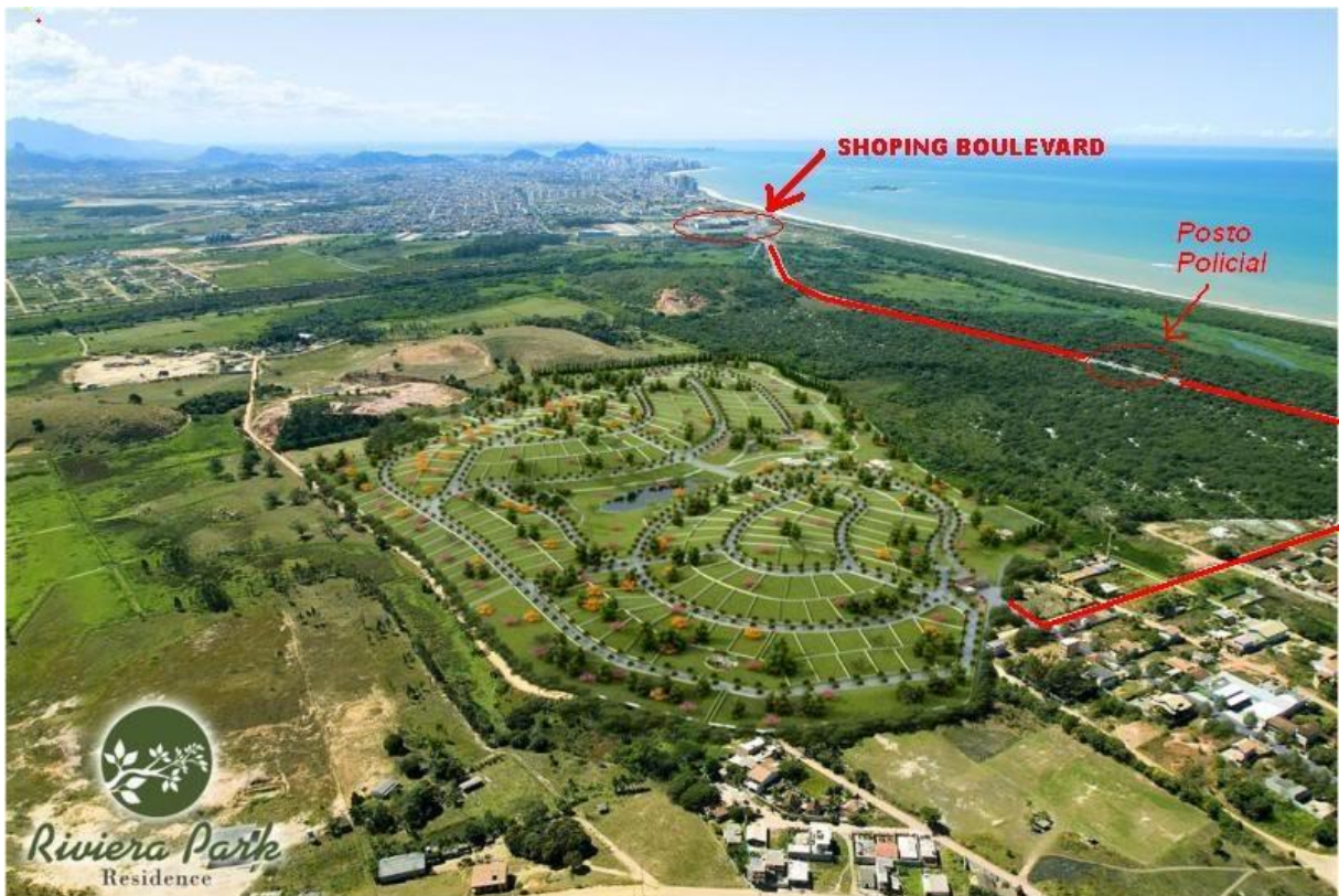
Figura 122 - Riviera Park. Empreendimento da Galwan e construção pela construtora Ápia. O loteamento ainda não recebeu licença para construção da prefeitura, possuindo apenas a divisão dos lotes e as vias de acessos pavimentadas.
