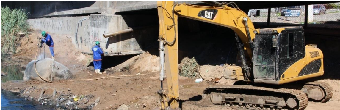
Figura 85 - Obras de dragagem e demolição de rochas do Canal da Costa. Foto: site da PMVV.
