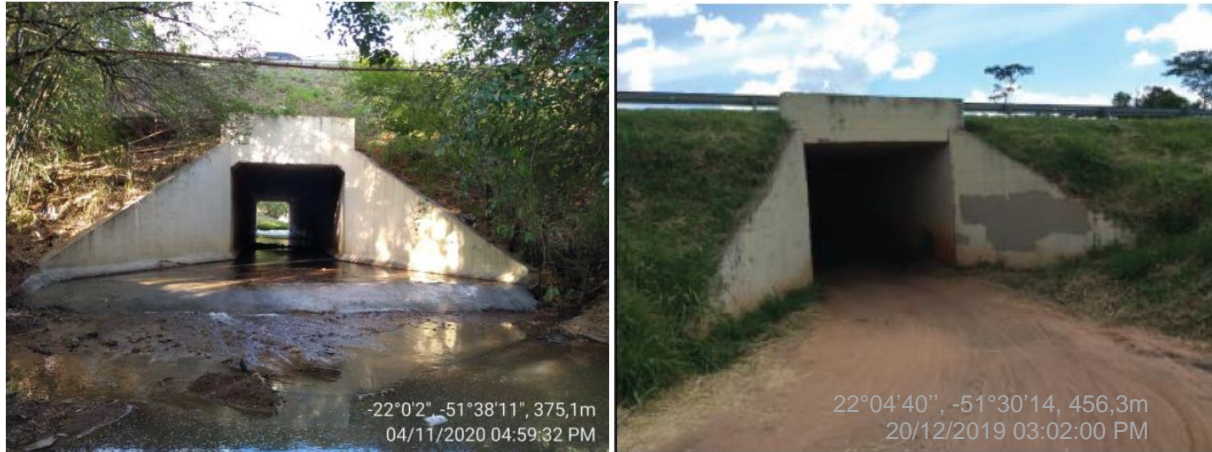
Figura 3-2: Vista de passagem inferior de fauna úmida (associada à curso d'água) à esquerda, e passagem inferior de fauna seca à direita.
