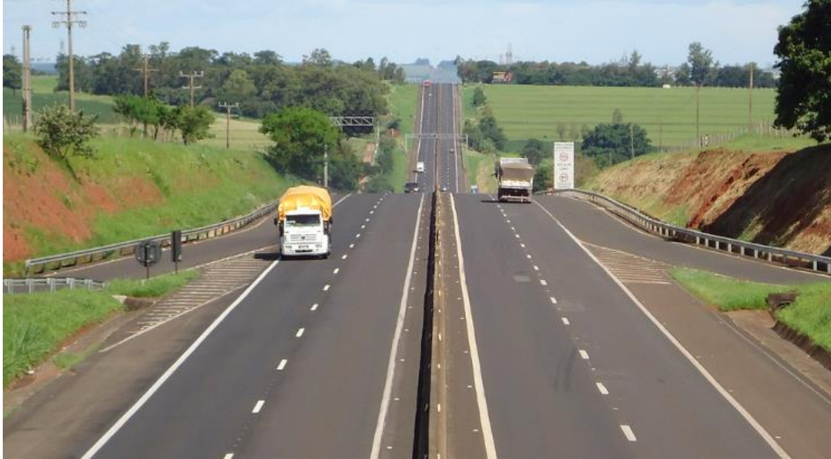
Figura 6.1-2: Vista da barreira New Jersey no entre pistas, necessária a segurança do usuário, mas que proporciona incremento no número de animais atropelados.
