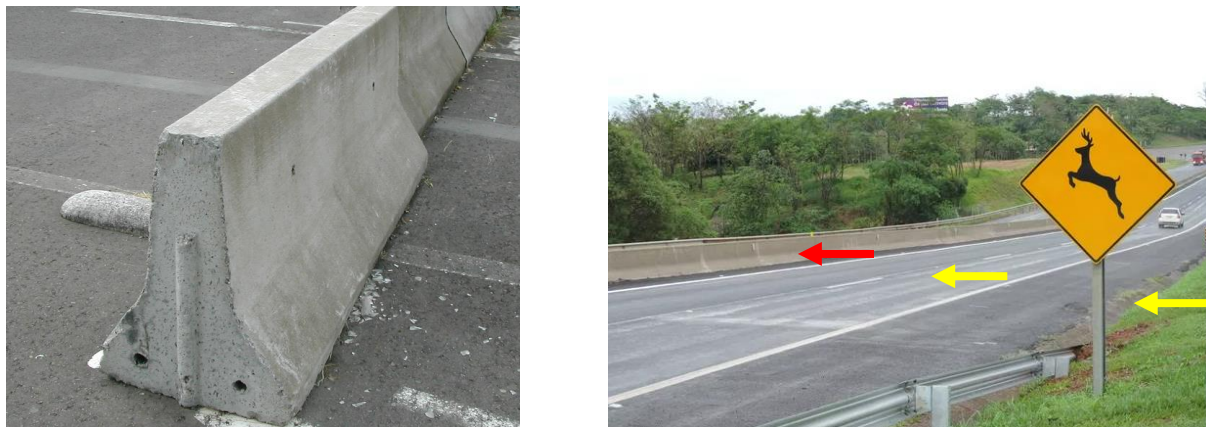
Figura 6.1-1: Detalhe de barreira New Jersey à esquerda, e fluxo de caminamento de animais à direita. Ao tentar atravessar a rodovia os animais deparam-se com situação intransponível, e ficam ilhados entre a barreira de concreto e o fluxo de veículos, expostos a atropelamento.
