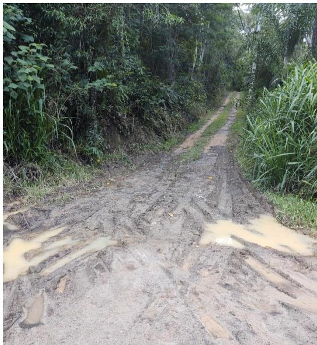
**Figura 5: Ausência de escoamento da água nas estradas por ausência de iniciativas de conservação e drenagem das estradas.**
