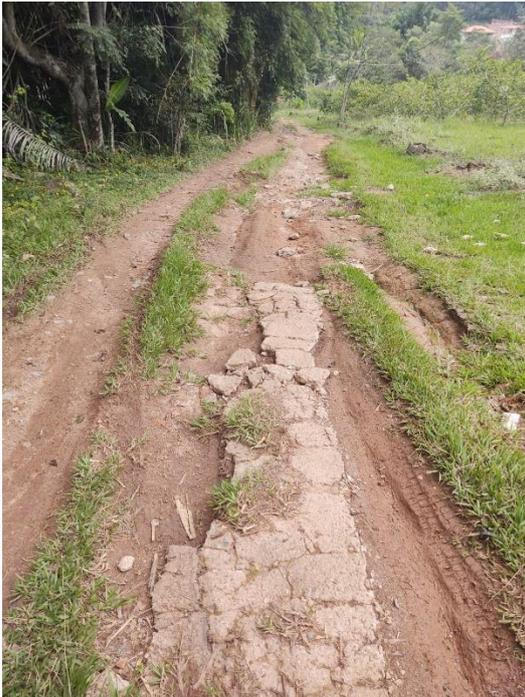
**Figura 3: Verificação do estágio de erosão da estrada interna em uma das propriedades**
