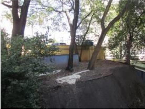
**FIG. 34 - RECORTE DO TERRENO PARA INSERÇÃO DO PRÉDIO ABAIXO DO NÍVEL DO MORRO**
