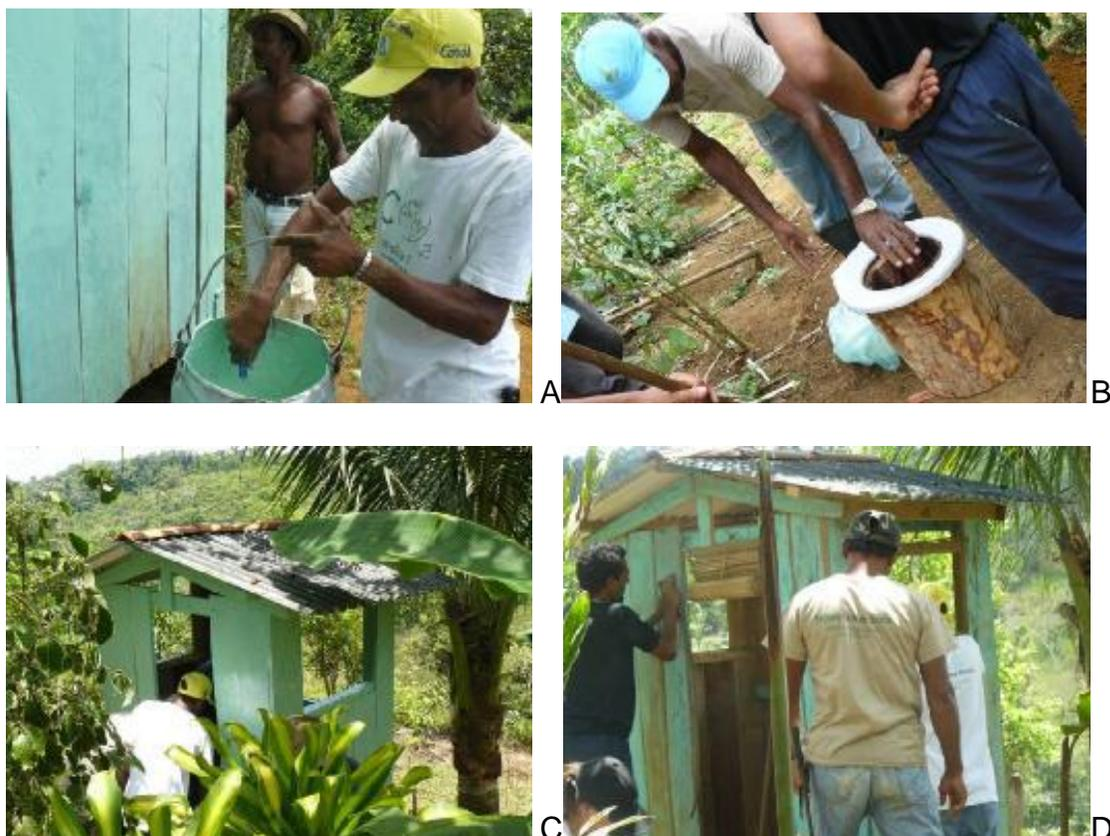
**Figura 16:** Construção de banheiro seco:
