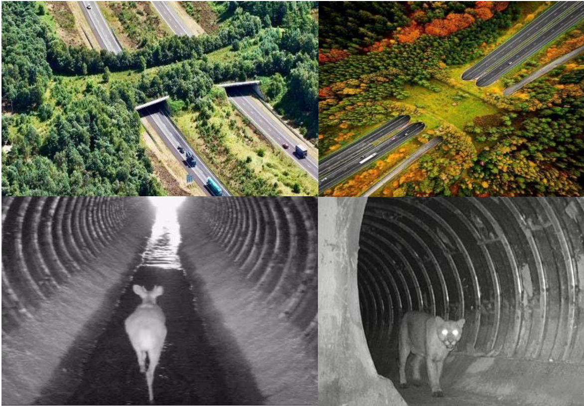
Figura 6 – Transposição com vegetação nas rodovias para animais de grande porte e de pequeno porte.
