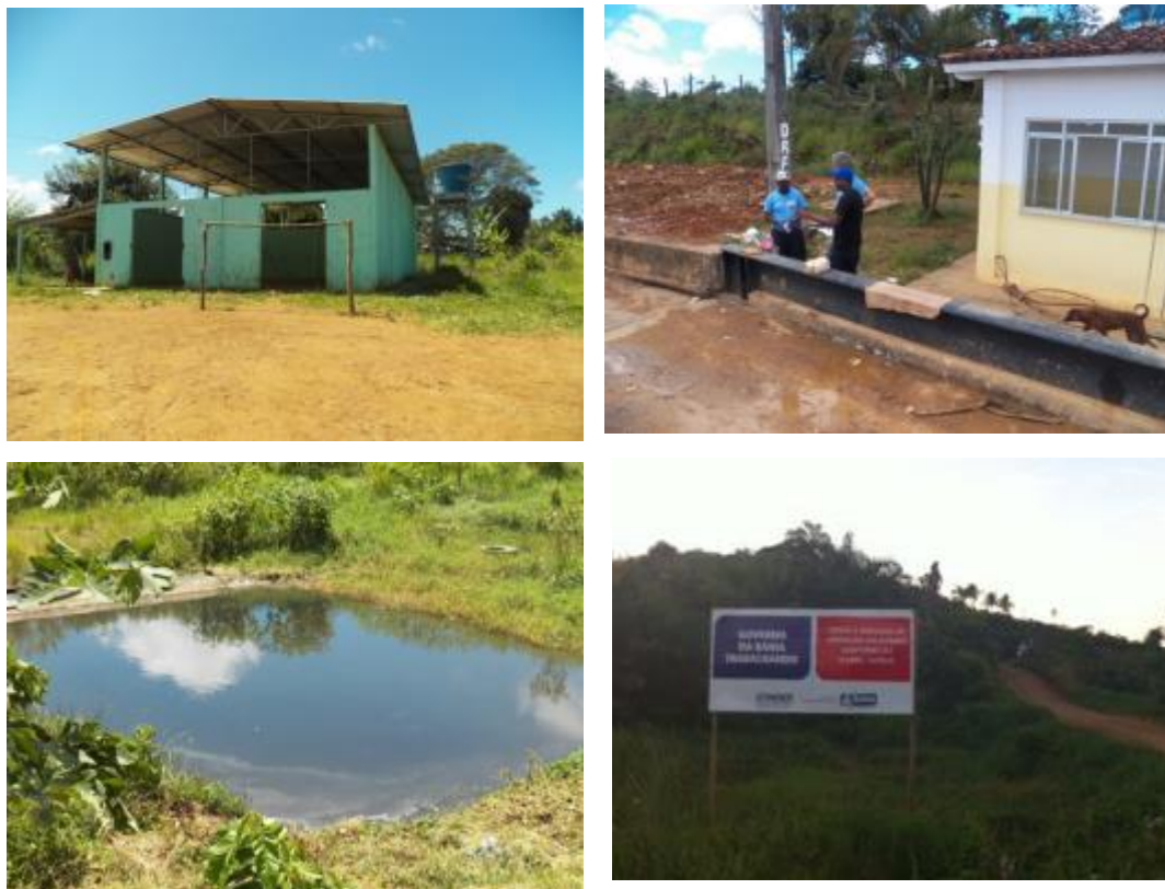
Figura 19: De cima para baixo, da direita para esquerda: Galpão de triagem, balança para veículo, tanque de chorume e placa de identificação do projeto de construção do “Aterro Sanitário” Tarirí. (Araújo, 2013).
