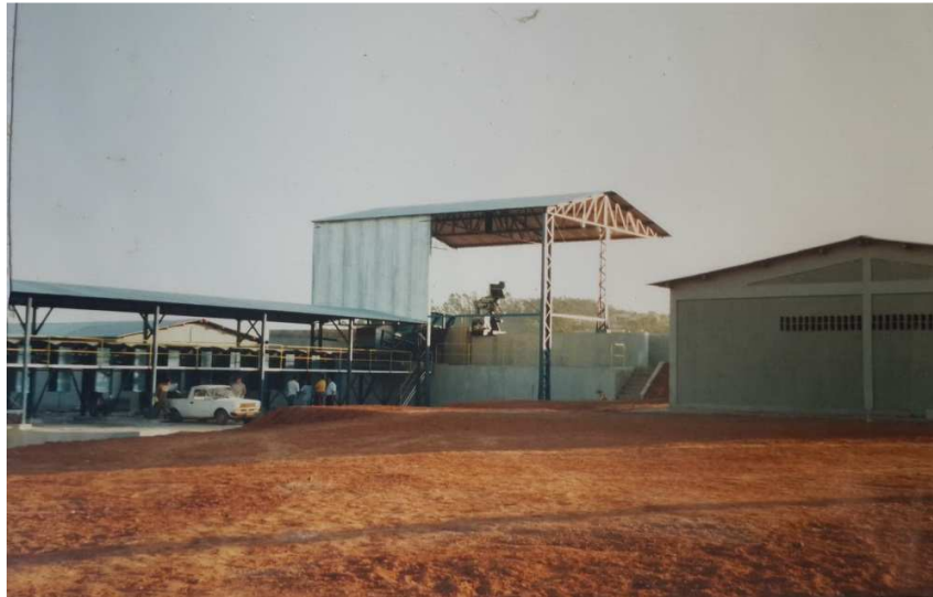
Figura 8. Galpão e esteira utilizados na separação de lixo. (Foto: Ricardo dos Santos Antônio).
