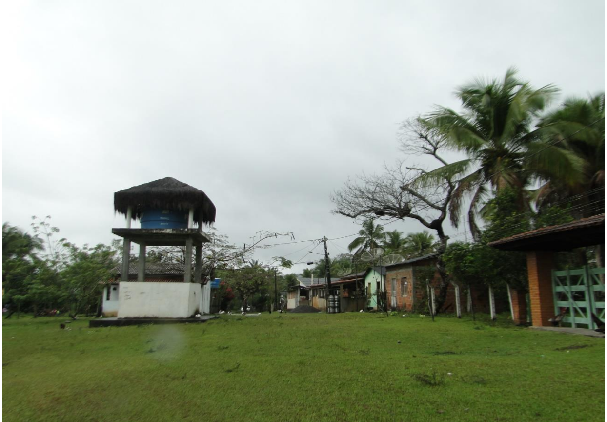
Foto 18: Segundo posto construído utilizado na torre do Projeto. (Luiz Afonso Figueiredo, set. 2013).
