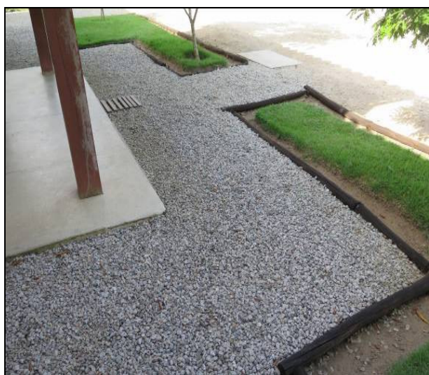
Fig.34: Área de circulação com brita para drenagem.
