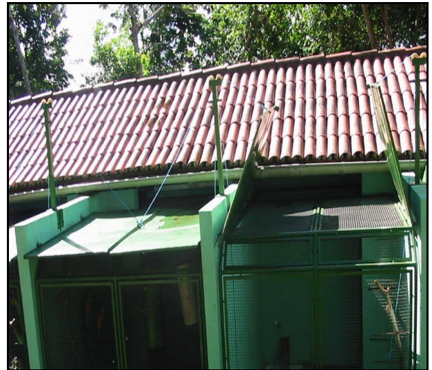
Fig.59: Solário com cobertura parcial e painéis móveis.
