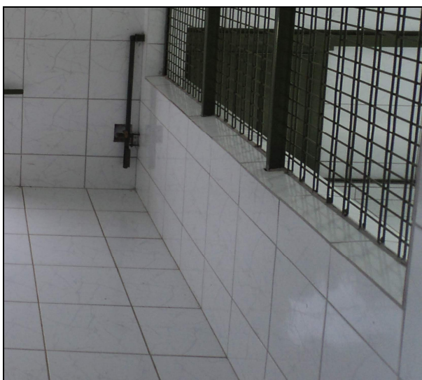
Fig. 84: Muretas ampliam o isolamento e protegem os metais contra a umidade e os resíduos.
