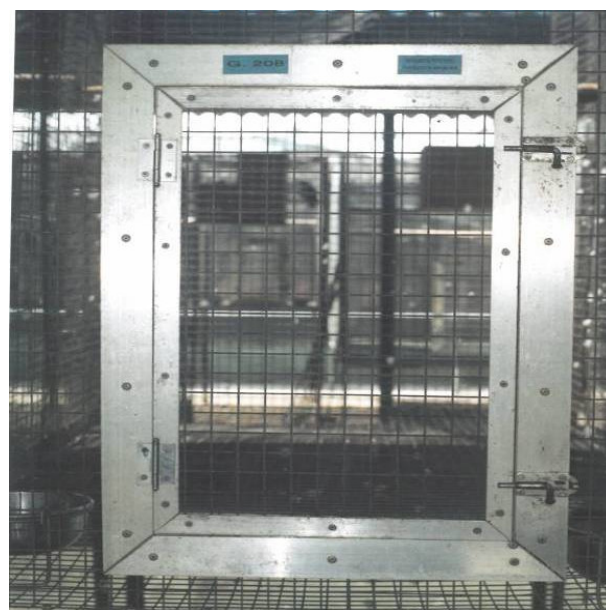
Fig. 30: Esquadrias de alumínio e tela galvanizada.
