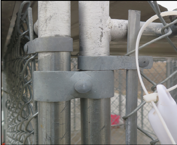
Fig. 98: Sistema de montagem de acomodações via encaixe, sem a necessidade de solda.
