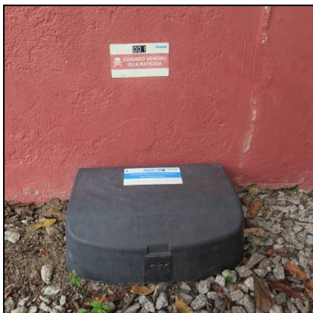
Fig. 89: Caixa isca para o controle de roedores.
