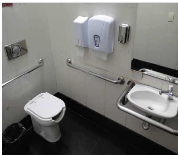
Fig. 33: Sanitário acessível para PNE.
