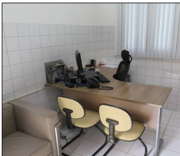
Fig 35:Recepção com revestimento cerâmico parcial
