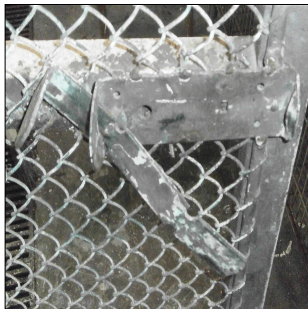
Fig.53: Ferrolho inadequado para o trabalho proposto.
