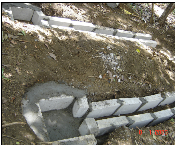
Fig. 68: Tocas subterrâneas sendo construídas para o enriquecimento ambiental de serpentes.
