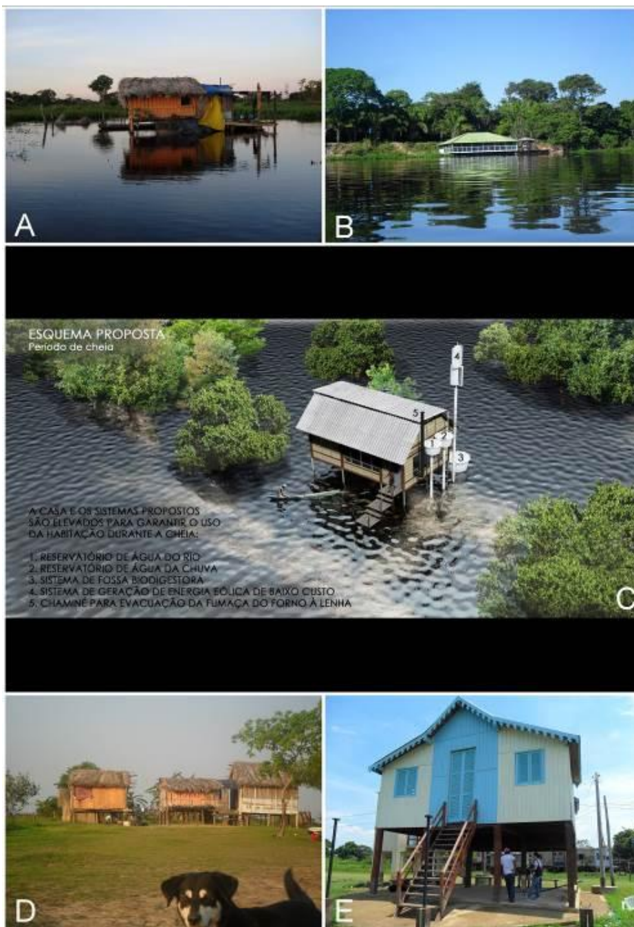
Figura 13: Representações/modelos de casas adaptadas aos ciclos das águas. Casas em palafita construídas na comunidade do Paraguai-Mirim (A e D). A figura C representa uma proposta criada pela ECOA, em parceria com um grupo de Arquitetos, como resultados do convênio MJ/SDE/FDD N°. 0084/2011. B representa uma casa flutuante na região de Barão de Melgaço (MT). E – Antiga Casa do Telégrafo, construída pelo Marechal Cândido Rondon, reformada pelo Governo do Estado de Mato Grosso do Sul.
