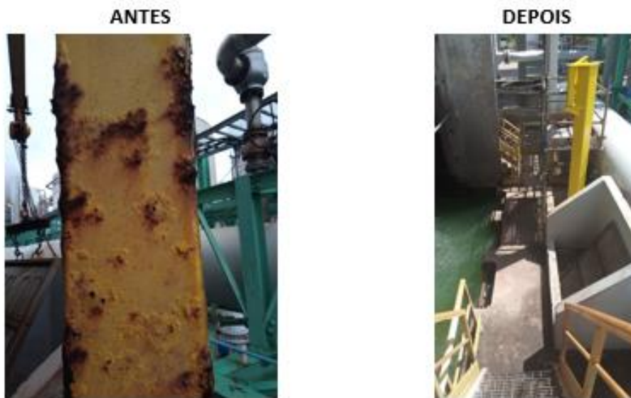
Figura 20 – Manutenção e pintura dos equipamentos de limpeza.
