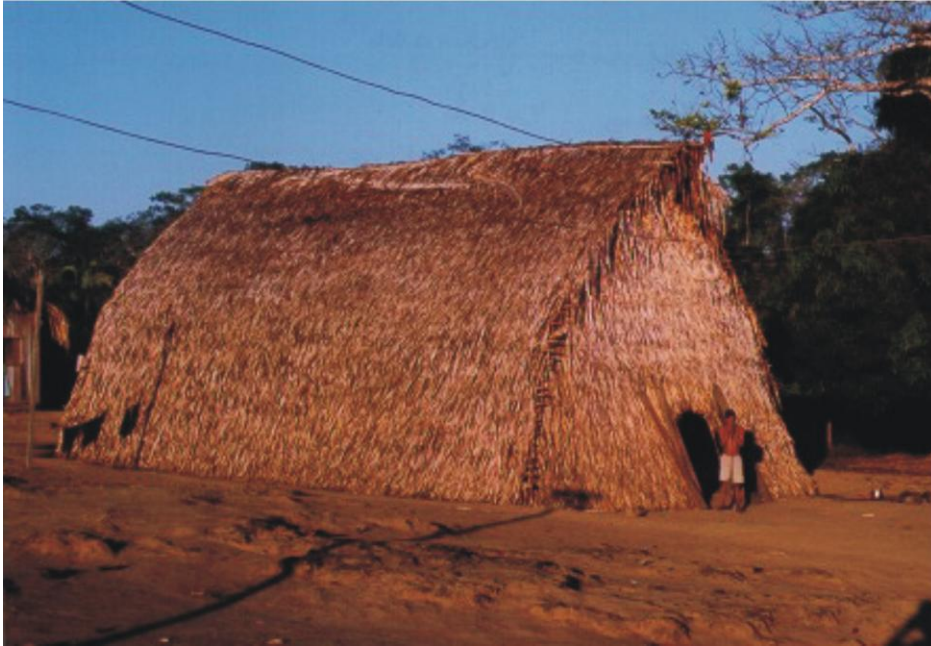
Figura 12: Antes do contato, os Jupau e Amondawa habitavam malocas retangulares, com tetos altos de duas águas e com saídas dos dois lados.
