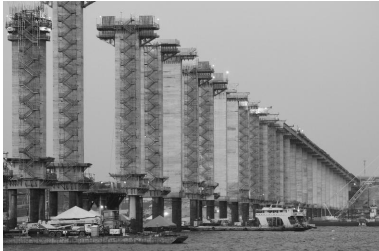
Figura 2: Ponte sobre o Rio Negro em construção, que liga os municípios de Manaus e Iranduba (Foto: Julia Coda, 2009).
