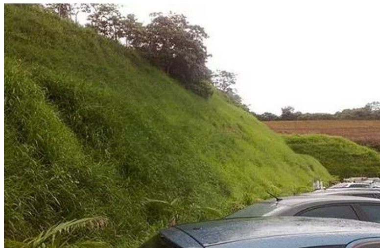
Figura 5 – Após Hidrossemeadura. Foto: Revest hidrossemeadura e consultoria
