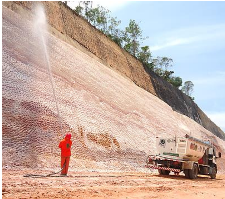
Figura 4 – Aplicação de hidrossemeadura. Foto: Revest hidrossemeadura e consultoria
