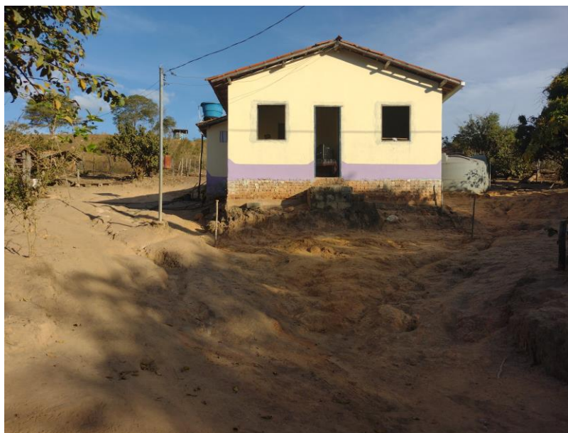
Figura 36 - Registro das primeiras casas de alvenaria construídas na comunidade do Tamboril com o apoio do Fundo Cristão no início dos anos 2000
