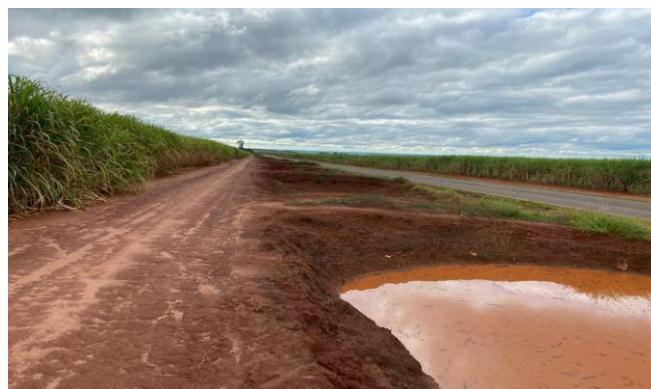
Figura 8 - Tecnologia para a contenção de água e controle de erosão do solo
