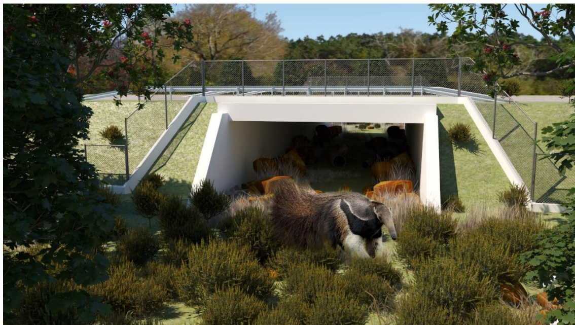
Figura 2 - Modelo de estrutura para travessia de fauna a ser implementado em rodovias. Fonte: cortesia @Viafauna.
