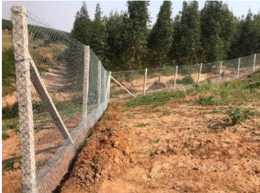
Figura 3 - Modelo de cerca direcionadora de fauna a ser implementado em rodovias. Fonte: Serpav.
